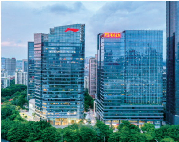
Shenzhen Li Ning Center
